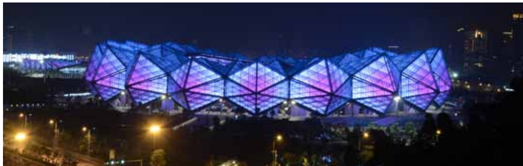
Eines der vielen neuen, grossartigen Stadien: Sicht aufs Leichtathletikstadion vom Village
